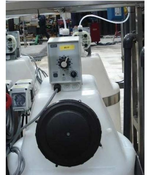
In genere hanno una bassa prevalenza (da 5 a 10 bar) e una altezza massima di aspirazione di 1.5 - 2 metri per cui si rende necessario posizionare la pompa appena sopra il contenitore con la soluzione da dosare (vedi figura a lato)
